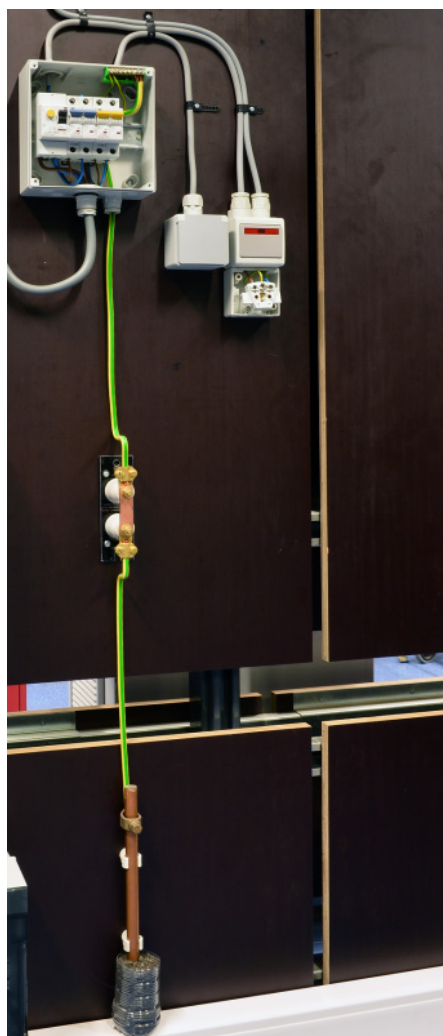
Figure 6 : installation de la prise de terre
